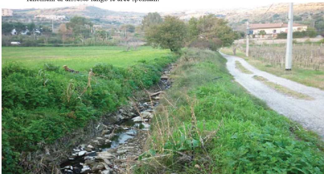
Foto 5 – L'alveo appare sufficientemente incassato rispetto al piano viario. In alto a sinistra quella che dovrebbe essere la conoide alluvionale.
