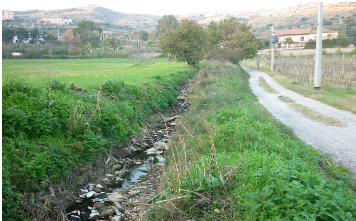
Figura 11: L'alveo appare sufficientemente incassato rispetto al piano viario. In alto a sinistra quella che dovrebbe essere la conoide alluvionale.
