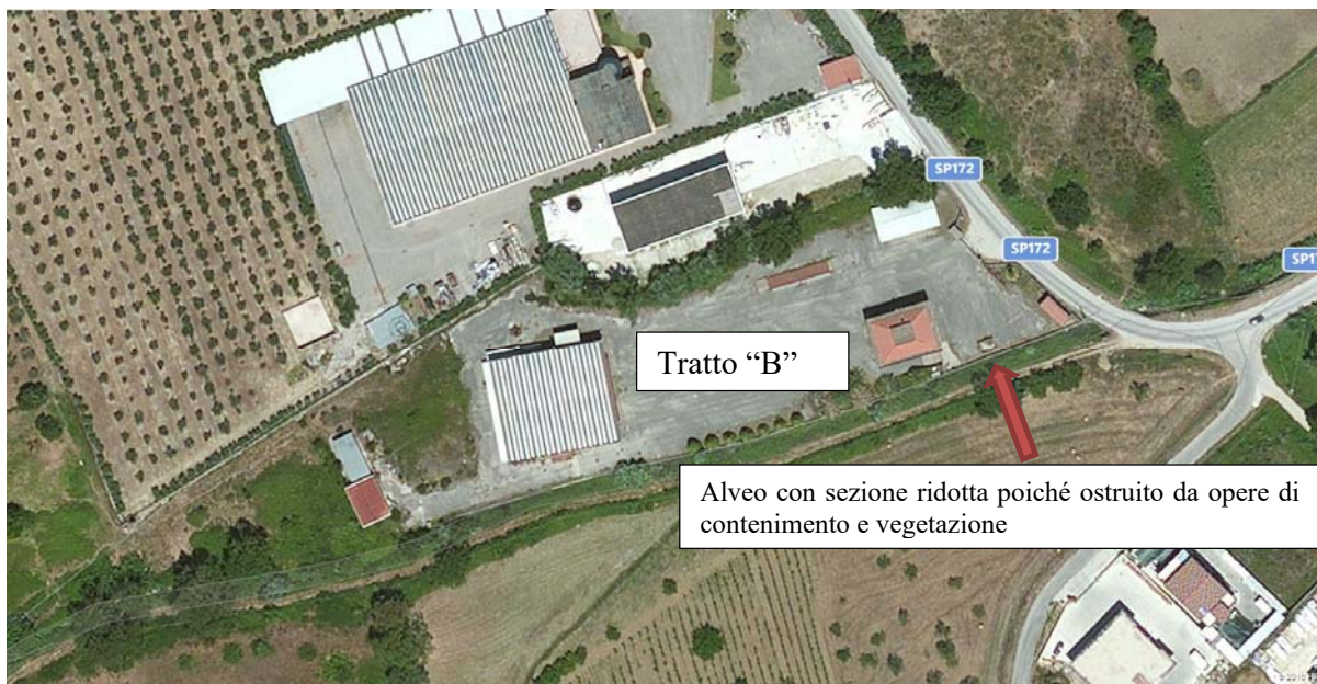
Fig. 4 – Particolare di uno dei punti di maggior criticità “restringimento dell’alveo”
